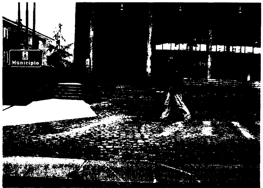
SCONNESSO Il dislivello e le pieghe mettono a rischio la sicurezza dei pedoni, soprattutto anziani
